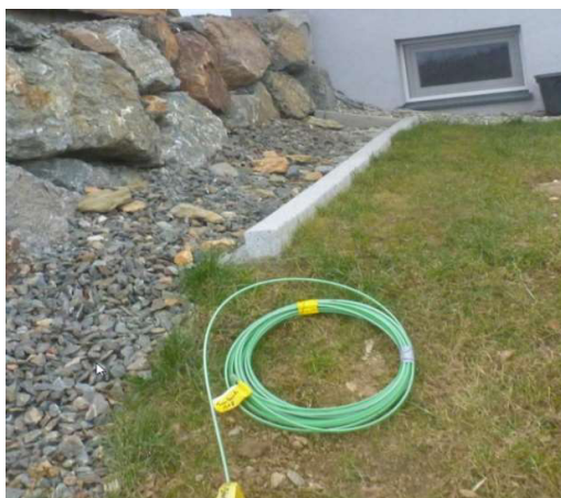
Abbildung 1: Abgelegter Röhrchenbund für weitere Verlegung durch Anschlusswerber
