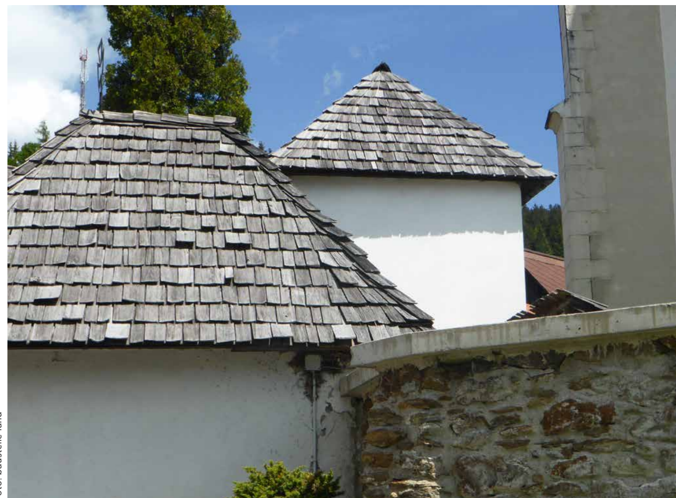
Foto: baustelle land
