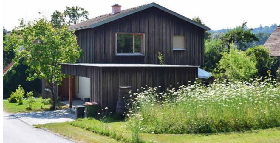
Foto: baustelle land
